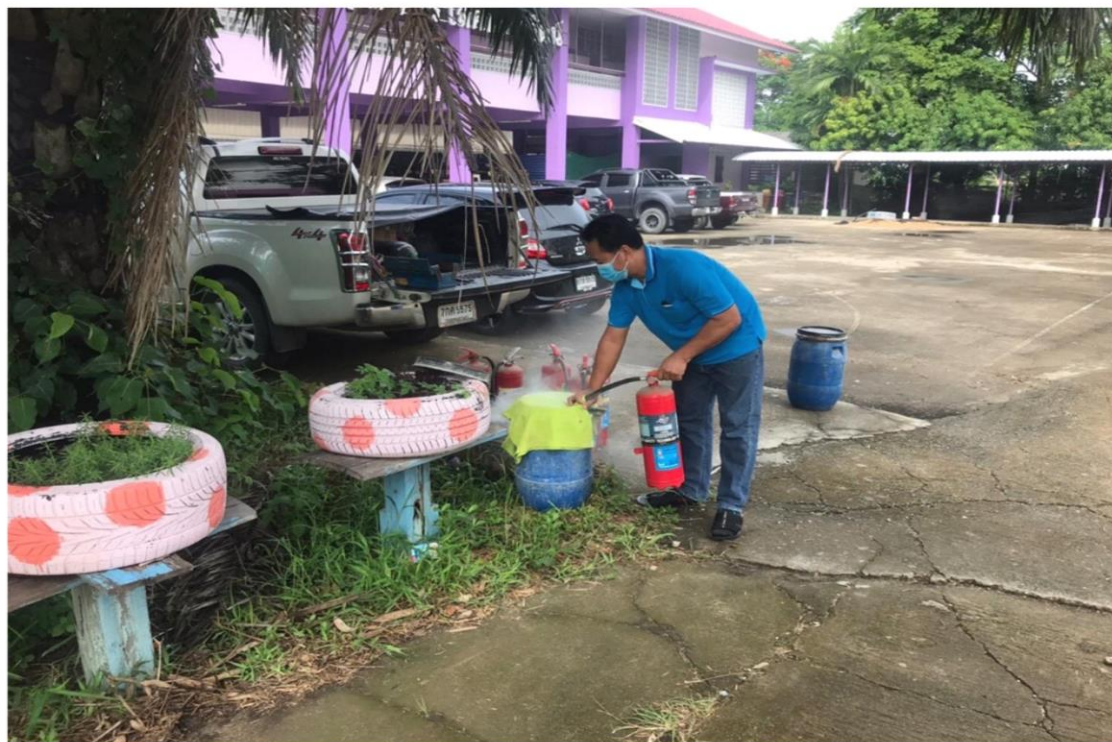
การเปลี่ยนเคมีถังดับเพลิง เติมน้ำถังดับเพลิง และซ่อมแซมถังดับเพลิงที่ชำรุด
