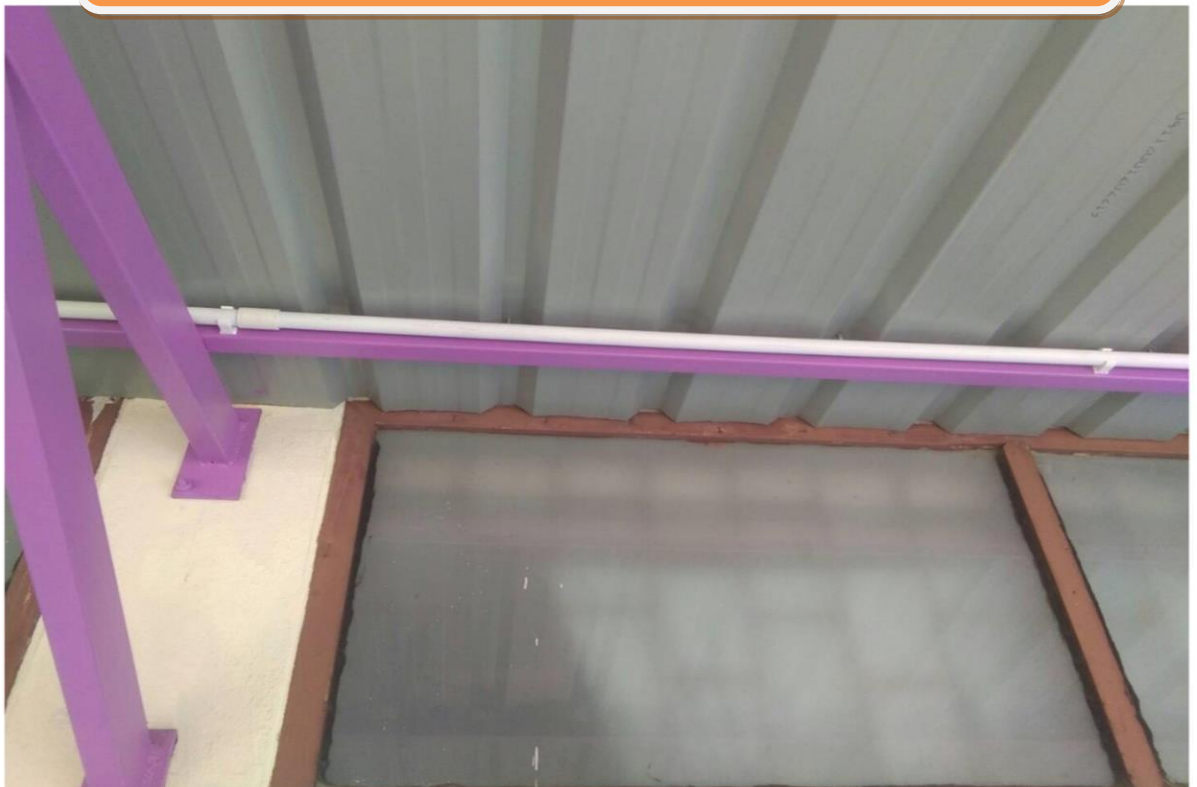
ผลการดำเนินกิจกรรมการปรับปรุง ซ่อมแซมอาคารสถานที่ และความปลอดภัยของโรงเรียน ประจำปีการศึกษา ๒๕๖๕ โรงเรียนวัดราชวรค์ศรีรัตนฯ (ปทุมธรรมโชติ)
