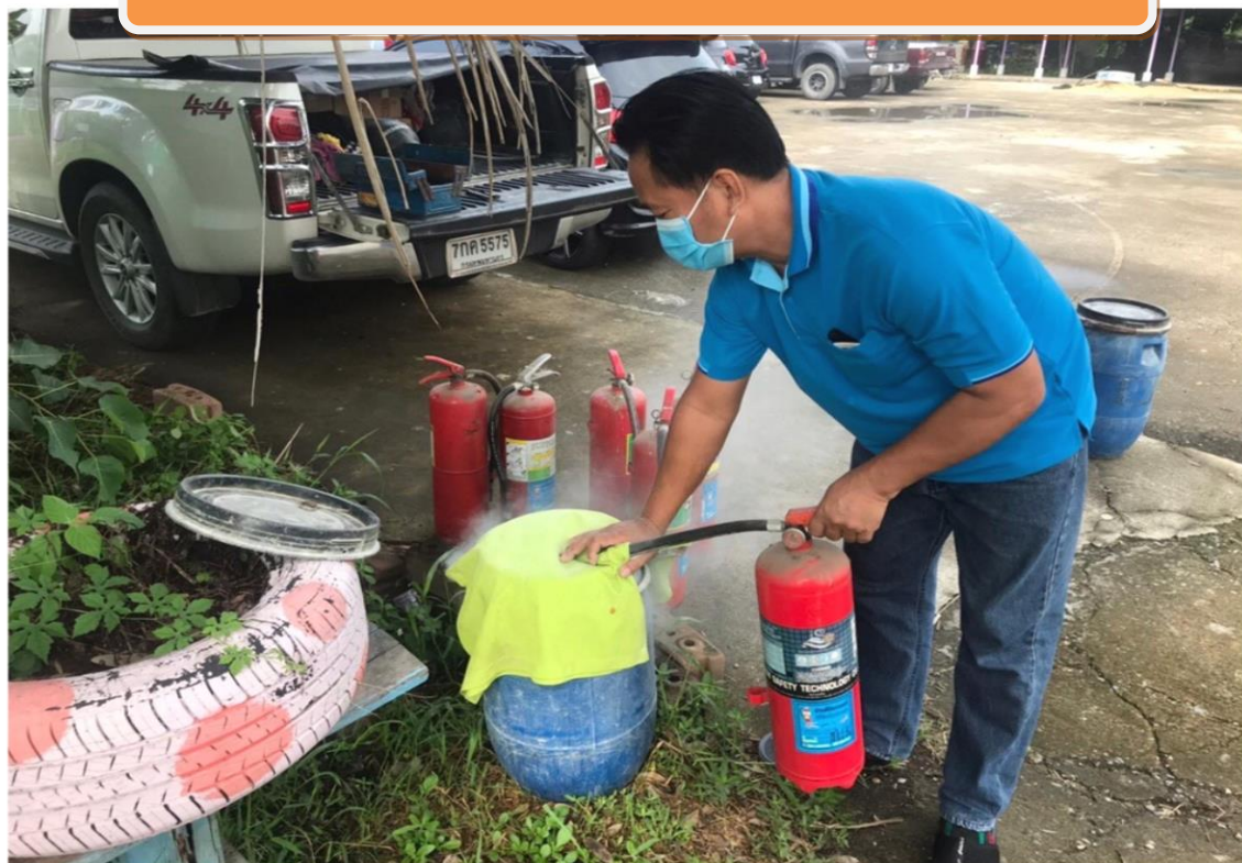
การเปลี่ยนเคมีถังดับเพลิง เติมน้ำถังดับเพลิง และซ่อมแซมถังดับเพลิงที่ชำรุด
